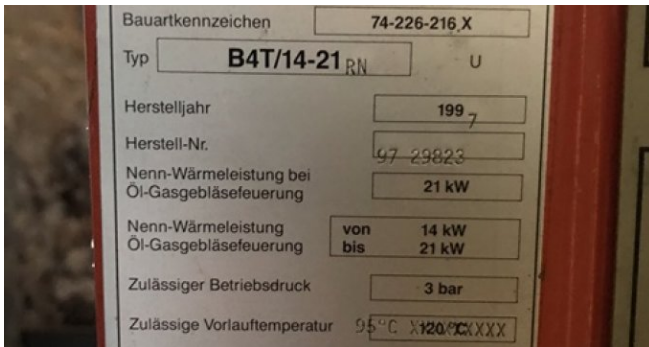
Heizung/ Typenschild
